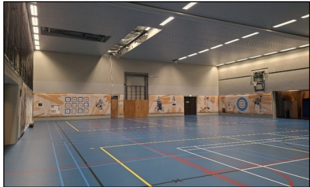
Figuur 2: Akoestische panelen met richtelementen in sporthal Lewenborg
