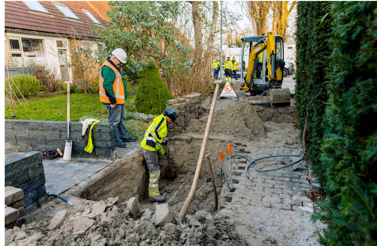
Tijdens werkzaamheden onder de grond is het belangrijk om het wortelpakket goed te beschermen. Daarom is er in Groningen een systeem van structureel toezicht op graafwerkzaamheden bij bomen.
