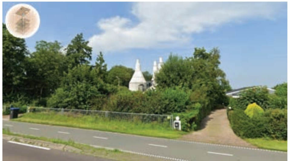
Een oude Kalkoven langs het Damsterdiep. Het is belangrijk op dit soort plekken behoud door ontwikkeling te stimuleren, door als gemeente actief mee te denken over herbestemming.
