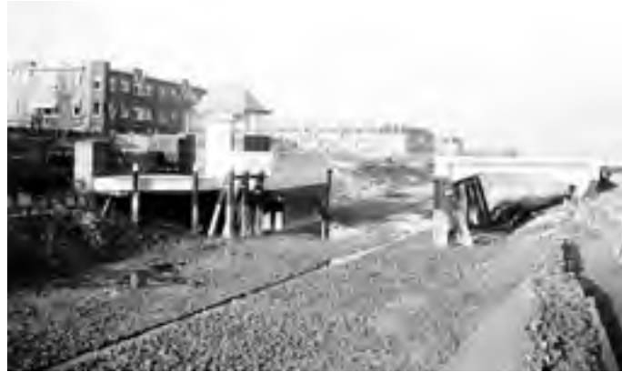
Aanleg Zaagmuldersbrug in 1938 (foto: Groninger Archieven)
