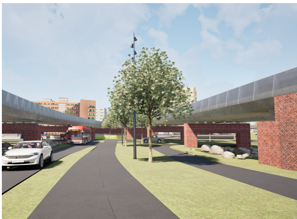
impressie insnijding met gemetselde onderconstructie
