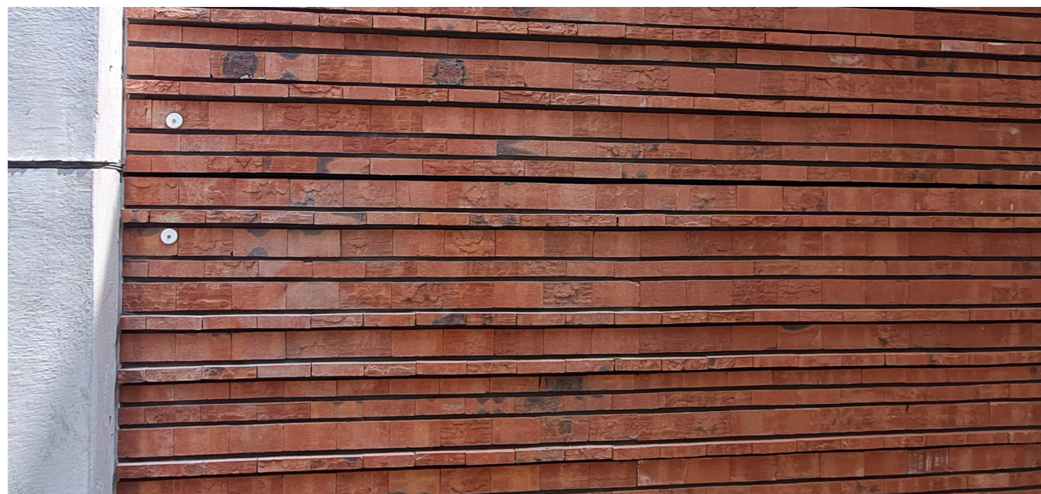
wanden insnijding - referentie metselverband en voeg
