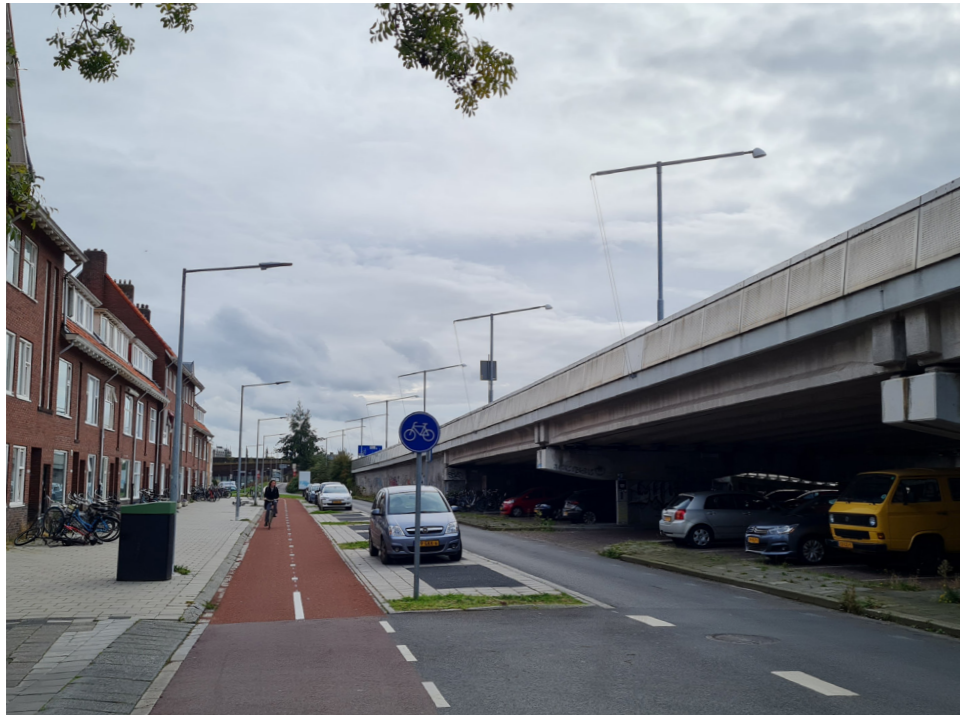
bestaande viaduct met gesloten leuningmen zuidelijke deel
