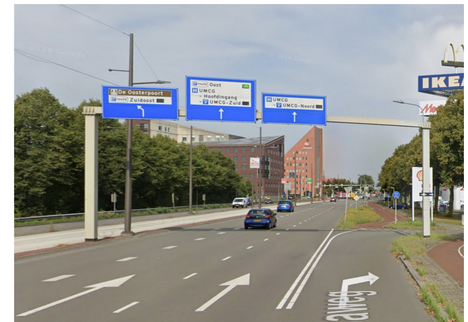
portaal met vierkanten buizen en coating
