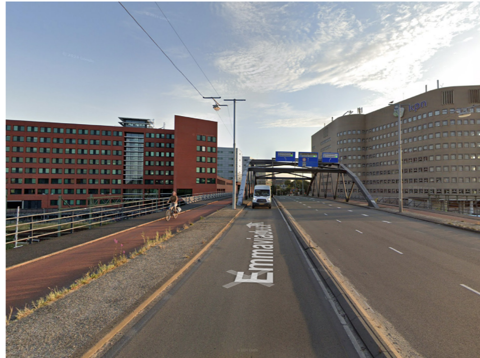
bestaande viaduct met lichte leuningmen - noordelijke deel
