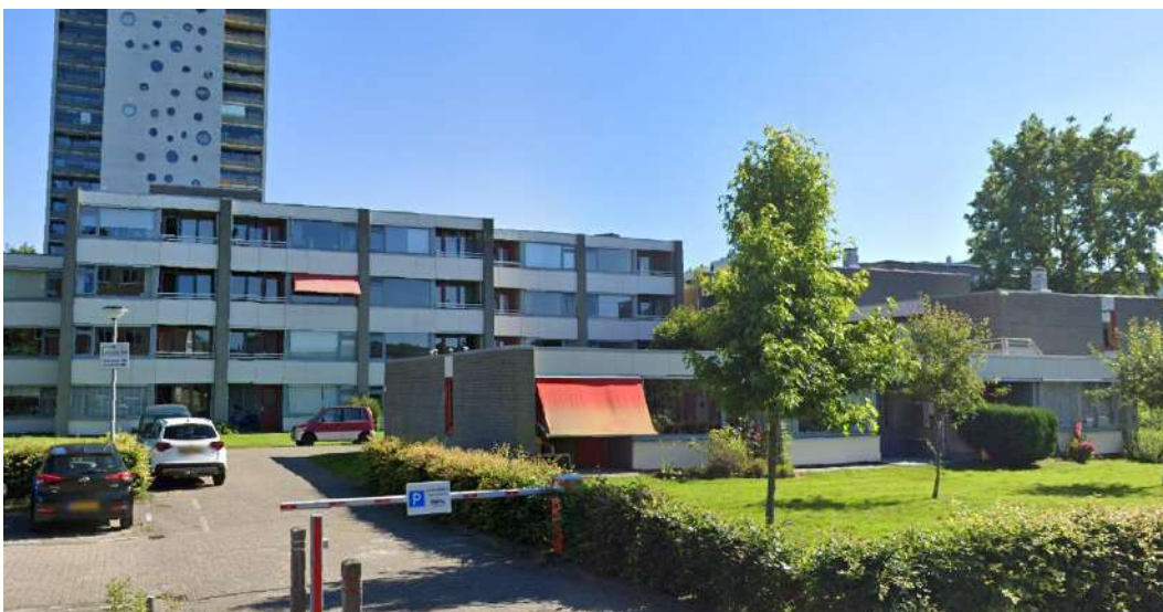
Figuur 2. Zuidzijde van het pand.
