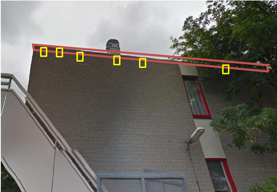
Figuur 9 Voorbeeld ruimte dakrim dichtzetten met rondschuim (rood omlijnd) en voorzien exclusion flap (gele vierkanten). En aanbrengen exclusion flap bij open stootvoeg (gele vierkanten).
