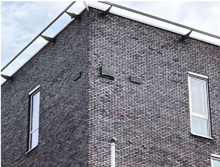
Figuur 7. Aangebrachte tijdelijke voorzieningen.
