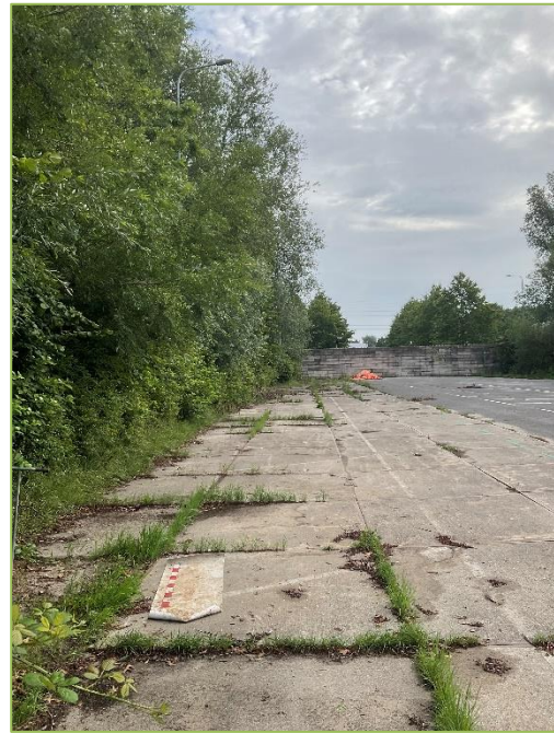
Figuur 25: Parkeerterrein van betonplaten binnen de kwetsbare boomzone.
