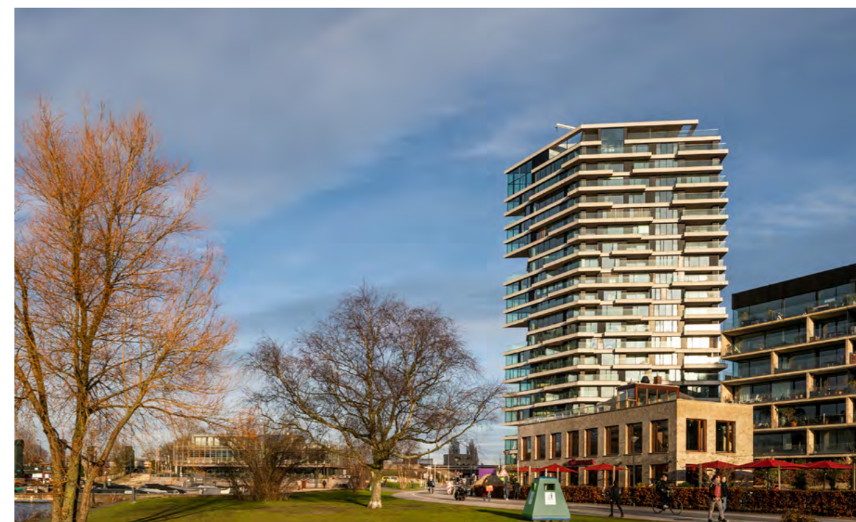
HAUT in Amsterdam is een hybride gebouw met houten draagconstructie (foto: Jannes Linders/Team V Architectuur)
