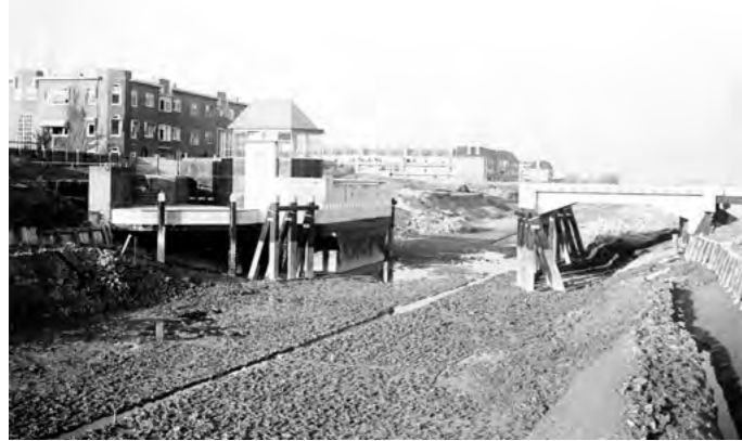
Aanleg Zaagmuldersbrug in 1938 (foto: Groninger Archieven)
