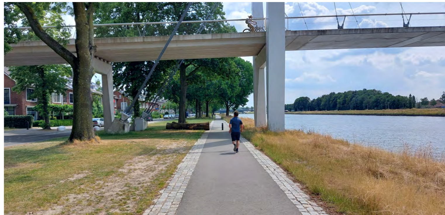
Een doorgaande parkzone langs het Van Starckenborghkanaal, de civieltechnische kunstwerken zijn onderdeel van de route en geen barrière, Amsterdam-Rijnkanaal in Utrecht (foto: gemeente Groningen)
