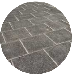
TROTTOIRS LIGGEN GROTENDEELS VRIJ VAN DE RIJBAAN GESCHIEDEN DOOR PLANTVAKKEN EN ZIJN UITGEVOERD IN BETONTEGELS (HERGEBRUIK)
