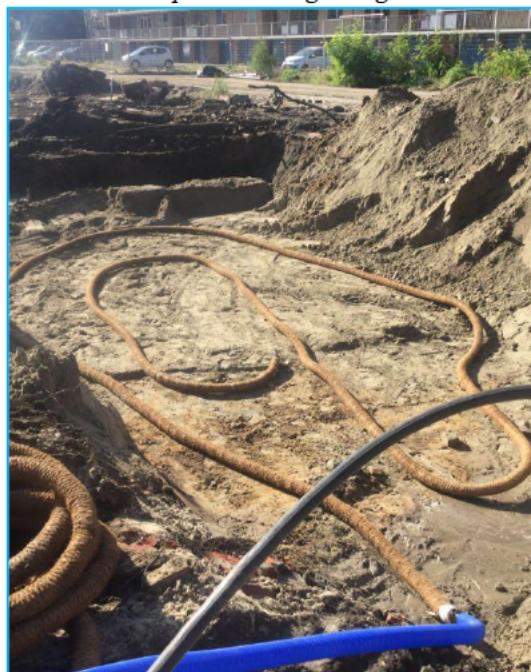
Foto 3: drain op bodem ontgraving
