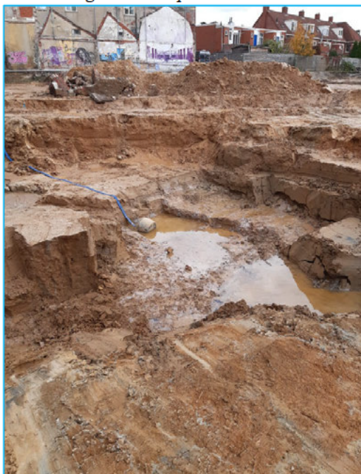
Foto 2: ontgraven oliespot
