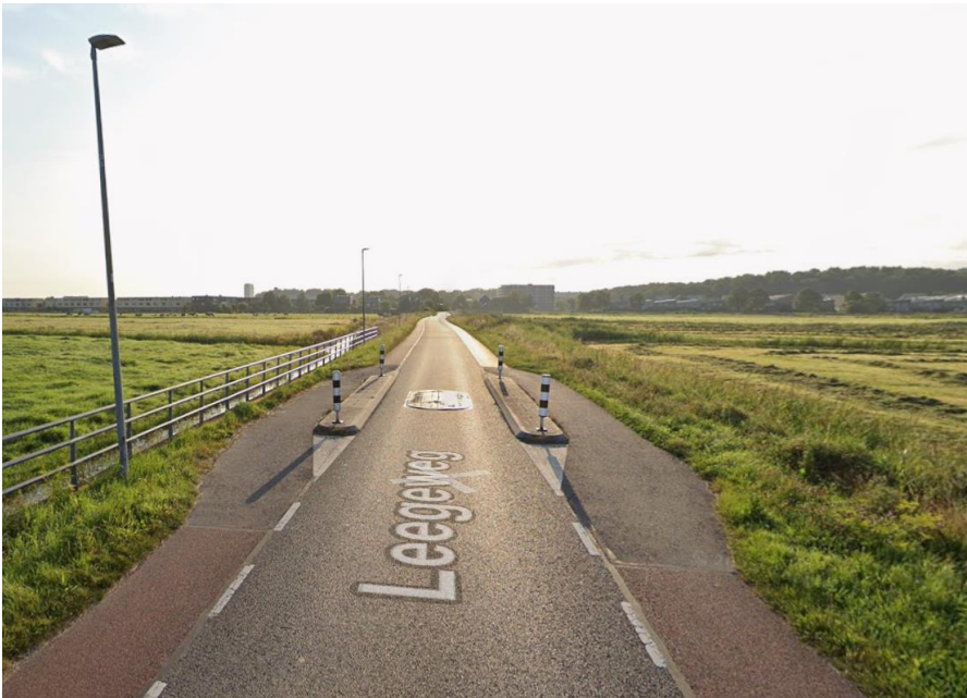
Figuur 8: Busvriendelijke snelheidsremmende maatregel op de Leegeweg
